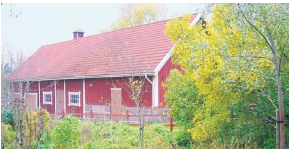
„ Faluröd “ nennt man das typische Rot der schwedischen Häuser, so wie hier in Näs. Denn aus Falun stammt die Farbe, die Eisen, Kupfer und Zink enthält. Sie wurde verwendet, um Backsteinbauten nachzuahmen. FOTOS (7): NETT
